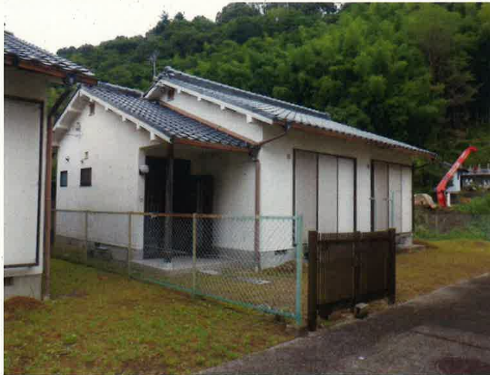
② 南西方より(140-16)
