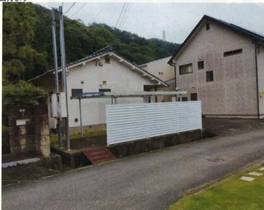
③北西方より
